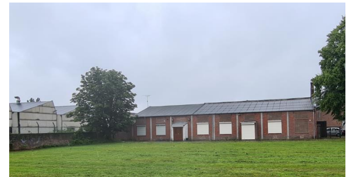
Figuur 6: Plangebied gezien vanuit het zuidoosten, met rechts de kerk en links de fabriekshal
