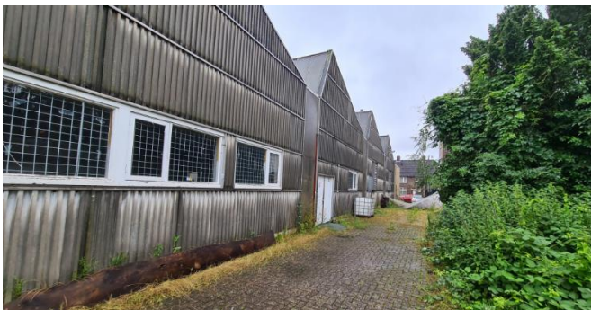
Figuur 7: Fabriekshal gezien vanuit het oosten
